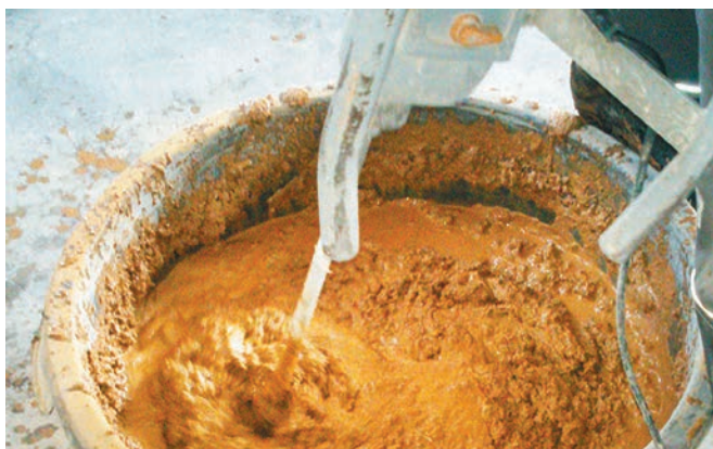
Rozmiešanie omietky nízkootáčkovým miešadlom
