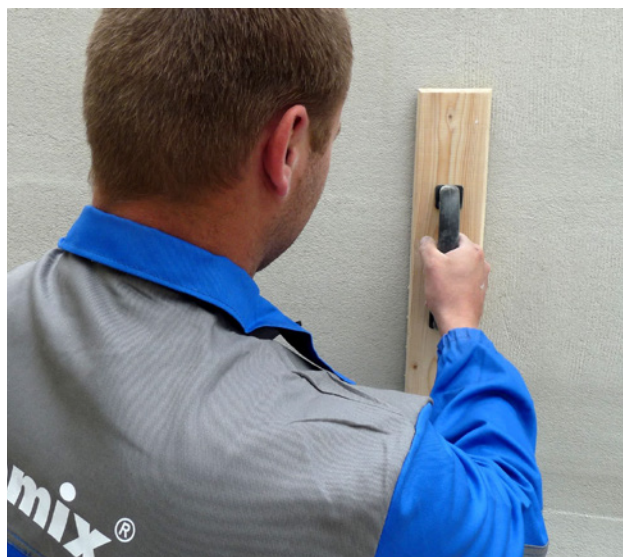
Zdrsnenie povrchu oceľovou škrabkou
