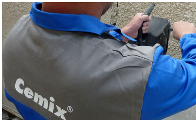
Aplikácia ručným striekaním / vytváranie striekanej štruktúry
