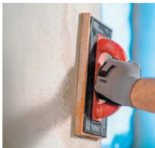
Úprava povrchu filcovaním
