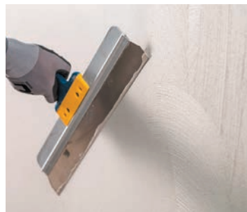
Úprava povrchu gletovaním
