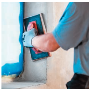
Úprava špalety po výmene okna
