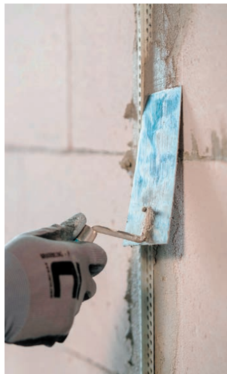
Osadenie omietkového profilu
