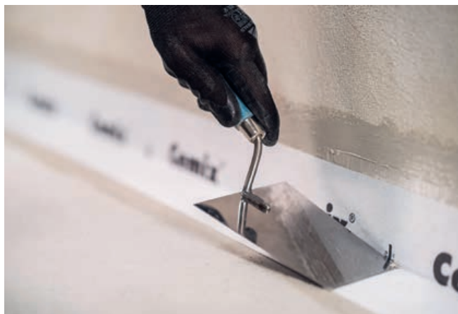
Pružná tesniaca páska v prvej vrstve hydroizolácie
