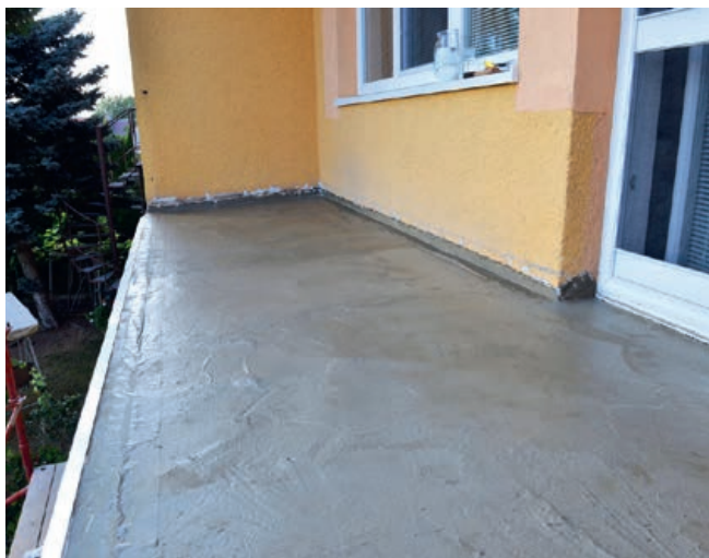
Hydroizolácia v dvoch náterových vrstvách
