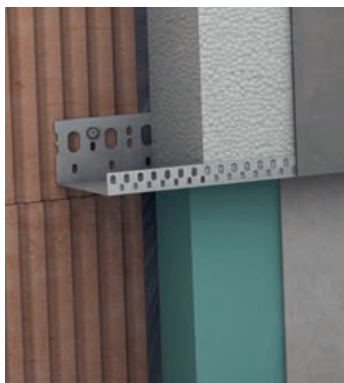
Osadenie základovej lišty a extrudovaného polystyrénu
