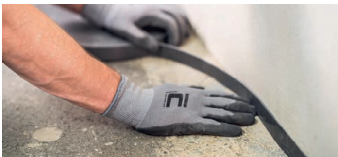
Umiestnenie dilatačnej pásky 5903 SAMOLEPIACA DILATAČNÁ PÁSKA 3/30 Umiestnenie dilatačnej pásky 5901 DILATAČNÁ PÁSKA S FÓLIU
