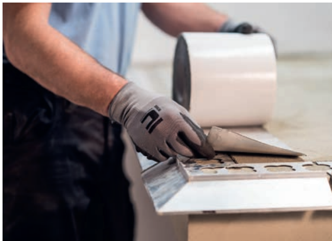
Upevnenie plechu pomocou samolepiacej butylovej pásky 8101 AQUASTOP TAPE FIX
