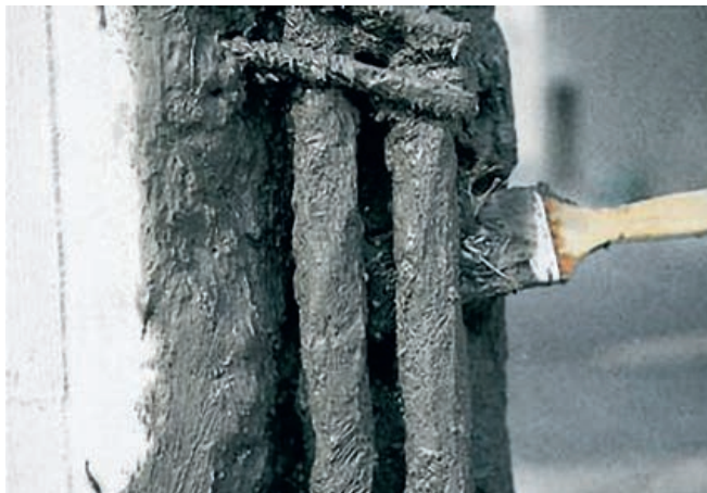
Aplikácia antikorózneho ochrany výstuže 1515 KONTAKT CT
