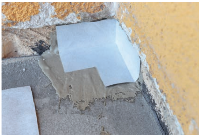
Použitie v rohu 8103 pre dokonalú vodotesnosť rohového spoja
