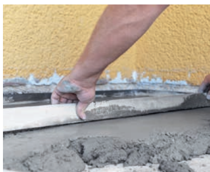
Vytvorenie spádového klinu
