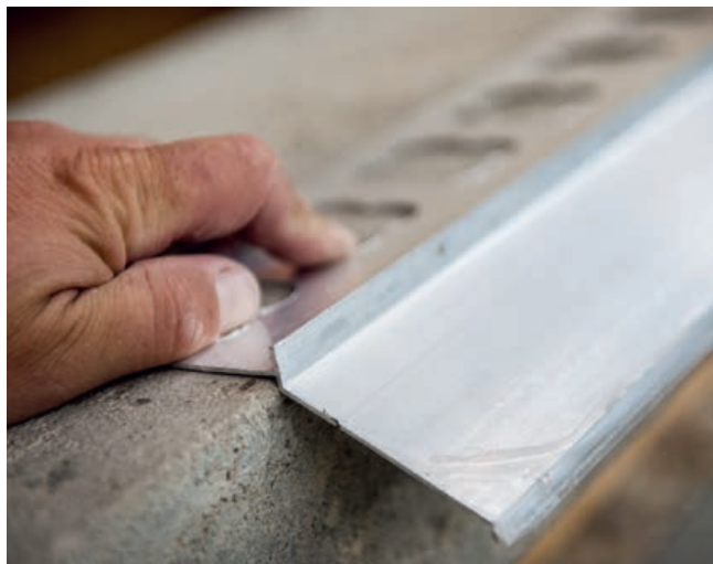
Dočasné osadenie profilu
