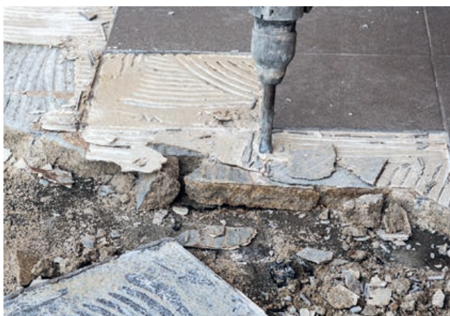
Odstránenie uvoľnených častí povrchu balkónov
