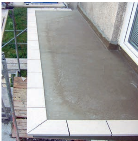
Montáž keramických tvaroviek
