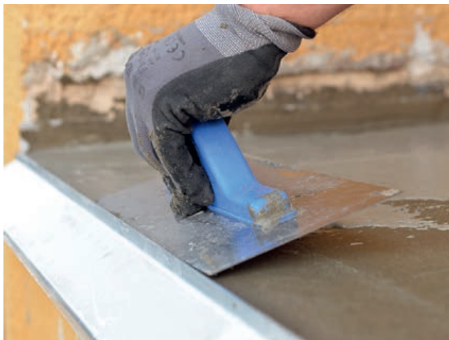
Hydroizolácia je natiahnutá až k okraju balkónového profilu
