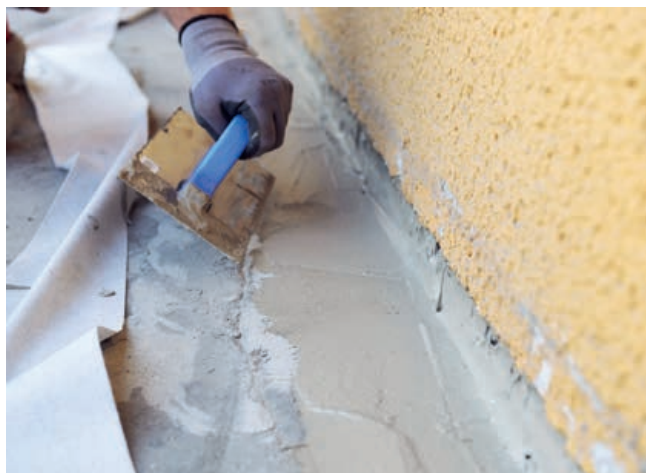
Prvá vrstva hydroizolácie pripravená na vloženie pružnej tesniacej pásky
