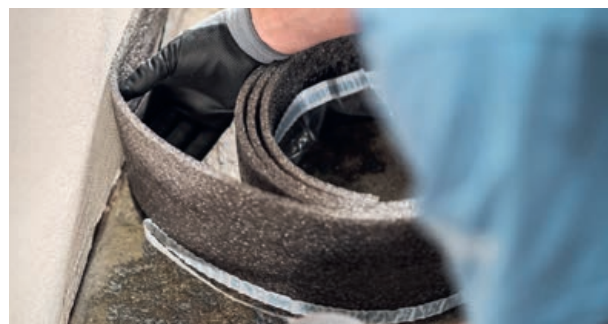
Umiestnenie dilatačnej pásky 5903 SAMOLEPIACA DILATAČNÁ PÁSKA 3/30 Umiestnenie dilatačnej pásky 5901 DILATAČNÁ PÁSKA S FÓLIU
