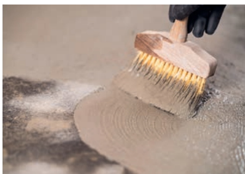
Aplikácia kontaktného mostíka 5050 KONTAKT ZE
