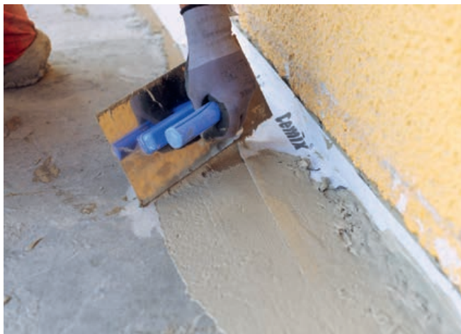
Nanášanie druhej vrstvy hydroizolačnej stierky
