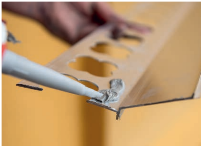
MS POLYMÉR na dočasné upevnenie profilu
