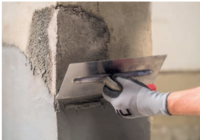
Nanášanie jemnej malty 1645 CT-MIX
