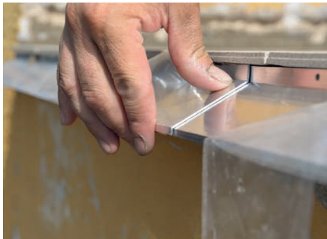
Upevnenie spojkou profilu
