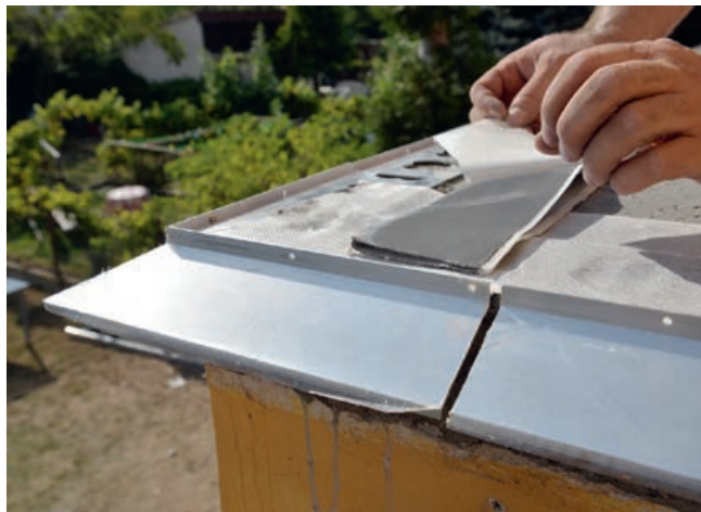
Potrebné medzery medzi profilmi
