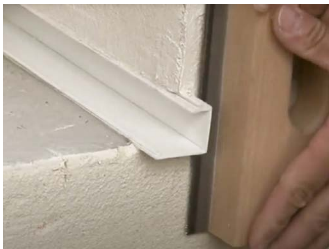
Zarezanie presahujúcej časti profilu SOL-PAD
