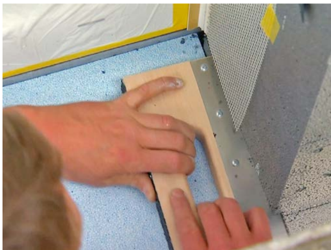
Príprava lôžka pre SOL-PAD – narezanie a vybrúsenie kapsy
