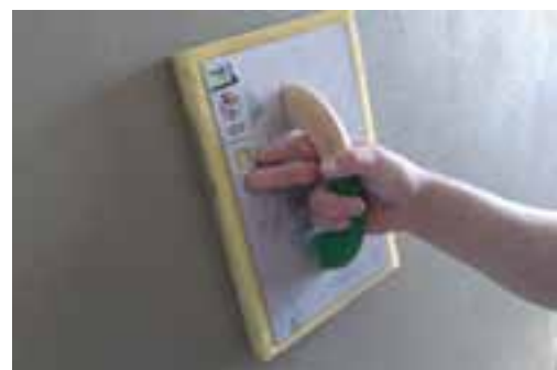
▲ Zatočení štukové omítky
