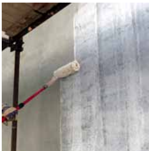
▲ Úprava podkladu penetračním nátěrem
