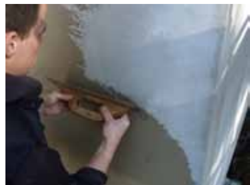
▲ Přestěrkování povrchu Cemix 155 Vyrovnávací stěrkou MULTI
