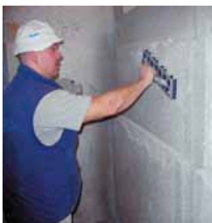
Zdrsnění povrchu tepelněizolační omítky škrabkou (celoplošně)
