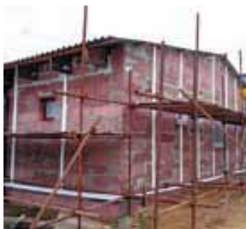
Stavba se ztracenými omítníky
