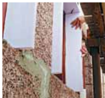
Ostění otvoru se zateplením polystyrenem
