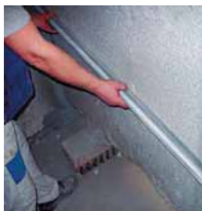
Zdrsnění povrchu tepelněizolační omítky lať (celoplošně)
