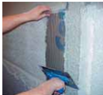
Vyztužení kritických míst sířovinou
