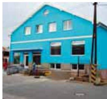
Finální úprava – nanesená Silikátová omítka na vyrovnávací vrstvu opatřenou penetrací
