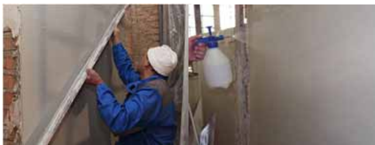
Zarovnání povrchu trapézovou latí (štosování)
