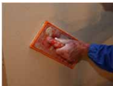
Rozfilcování povrchu houbovým hladítkem
