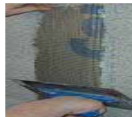
V místech přechodů vložte síťovinu do vyrovnávací stěrky
