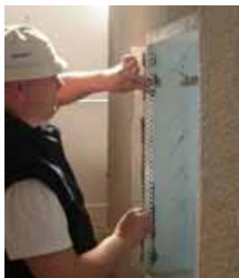
Hrany všech rohů včetně hrany ostění a nadpraží otvorů zpevněte rohovými lištami se síťovinou
