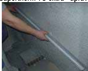
Zdrsňte povrch omítky latí (celoplošně)
