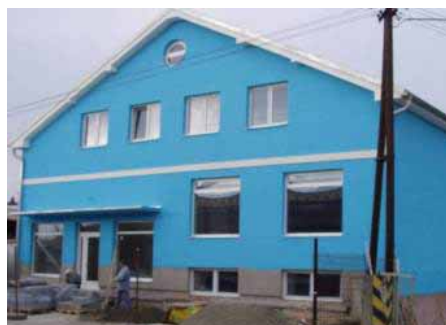
Finální úprava – nanášená Silikátová omítka na vyrovnávací vrstvu opatřenou penetrací
