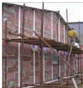
Stavba se ztracenými omítníky
