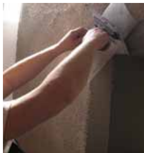
Kritická místa vyztužte síťovinou uloženou do vyrovnávací stěrky
