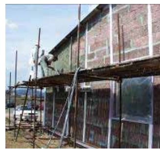
Na dřevoštěpové materiály tepelně izolační omítku naneste přímo na podklad (bez cementového postřiku).
