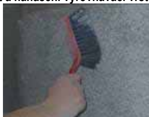
Omeťte prach ze zdrsněné omítky a povrch ošetřete penetrací
