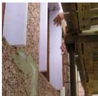
Osazení ostění otvorů polystyrénem
