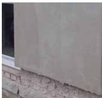
Vyrovňovací vrstvu přebruste a penetrujte pro nanášení štukové vrstvy (viz Alternativa Ib) nebo šlechtěné omítky (viz Alternativa IIb)
