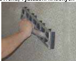
Zdrsňte povrch omítky škrabkou (celoplošně)
