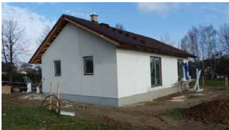
Obr. č. 3: Objekt opatřený základní vrstvou
