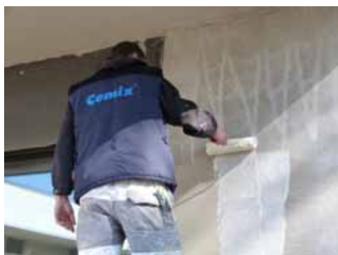
Obr. č. 4: Provádění penetračního nátěru
