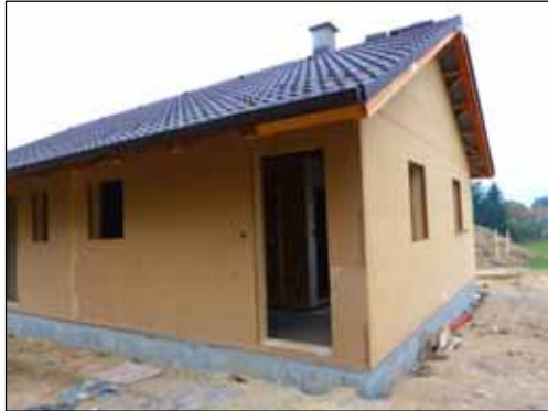
Obr. č. 2: Příklad opláštění dřevostavby dřevovláknitými deskami (vlevo) a vnitřní konstrukce dřevostavby
