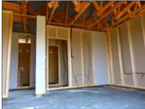
Obr. č. 2: Příklad opláštění dřevostavby dřevovláknitými deskami (vlevo) a vnitřní konstrukce dřevostavby
