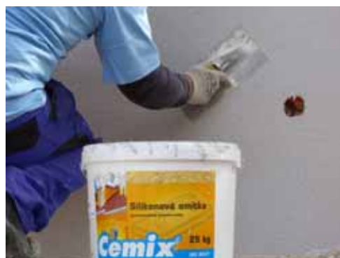
Obr. č. 5: Natahování strukturální omítky
