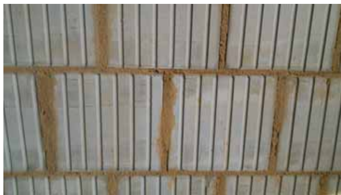
Obr. 2 – Promaltování vodorovných i svislých spár
