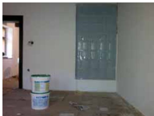
Obr. 10 – Hliněné omítky po provedení nátěru
