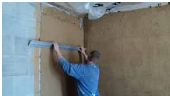
Obr. 6 – Stahování omítky latí
