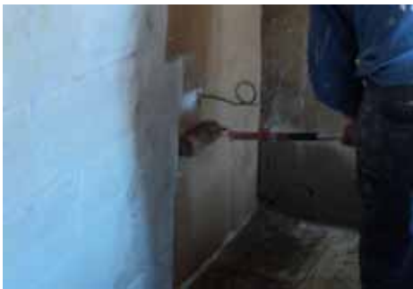
Obr. 3 – Nanášení spojovacího můstku válečkem
