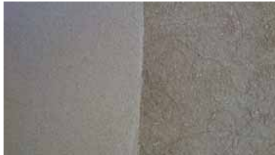
Obr. 8 – Jemná omítka na jádrové omítce
