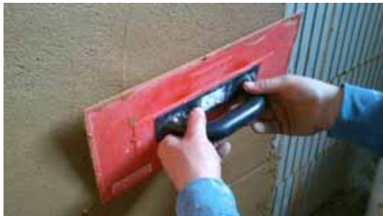
Obr. 7 – Natahování omítky hladítkem
