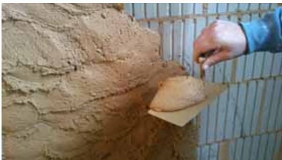
Obr. 5 – Nanášení omítky
