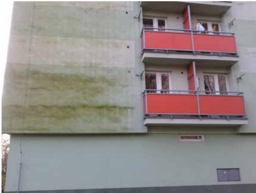
Obr. 1 – biotické napadení ETICS
