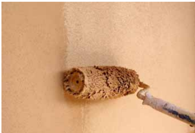
Obr. 3 - Provádění fasádního nátěru
