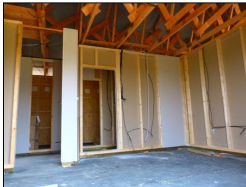
Obr. 3 Vnútrotná konštrukcia drevostavby
