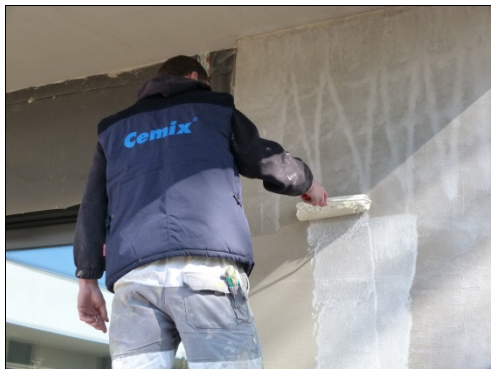
Obr. 5: Prevádzanie penetračného náteru
