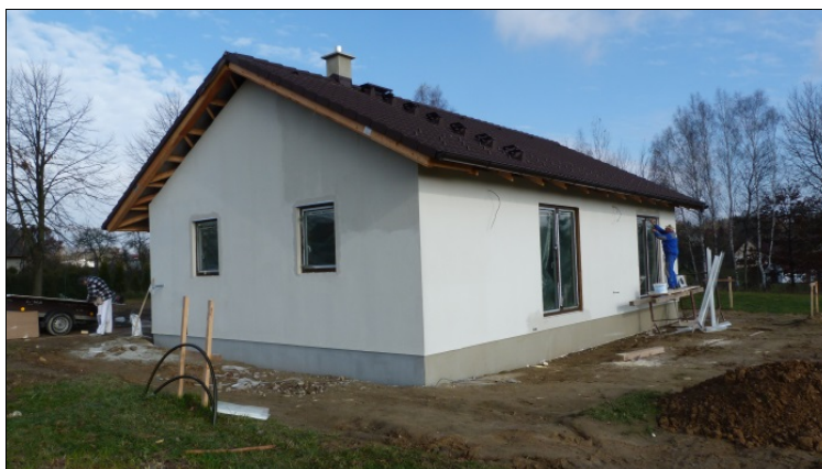
Obr. 4: Objekt zaopatrený základní vrstvou
