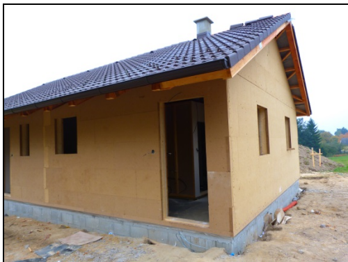
Obr. 2: Príklad opláštenia drevostavby drevovláknitými diskami
