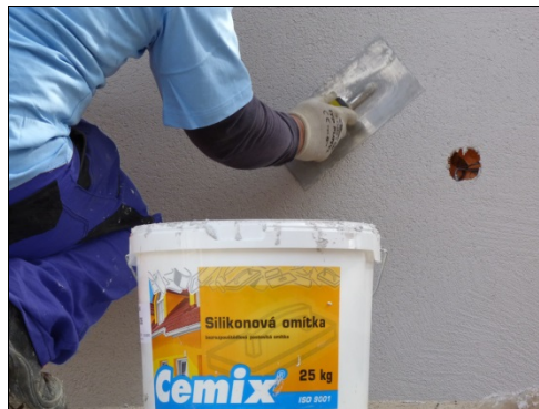
Obr. 6: Naťahovanie štruktúrálnej omltky
