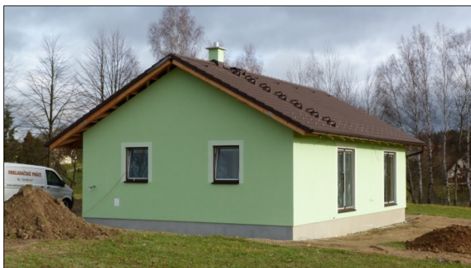
Obr. 7: Hotová fasáda objektu
