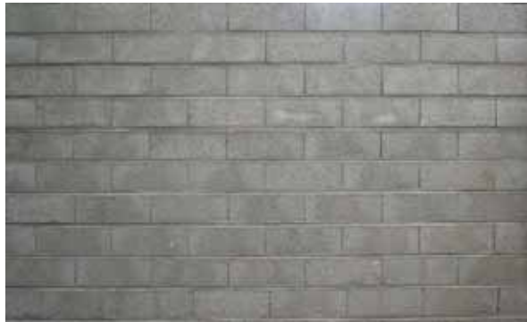
Obr. č. 1 – Zdivo z betonových skořepinových tvárnice
