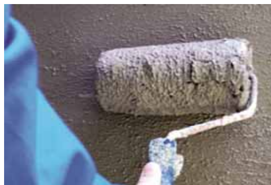
Obr. 2 Nanášení polymercementového můstku
