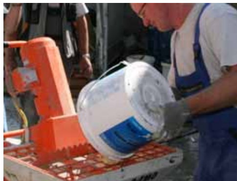
Obrázek 6: Plnění zásobníku pastovitou omítkou
