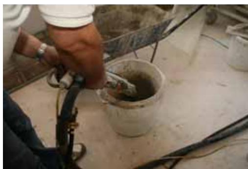
Obrázek 10: Zkouška a nastavení stroje
