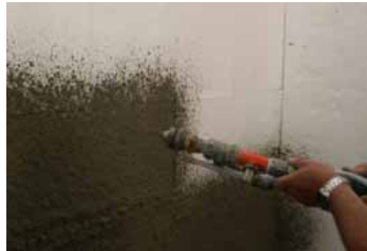
Obrázek 12: Nanášení stěrkové hmoty
