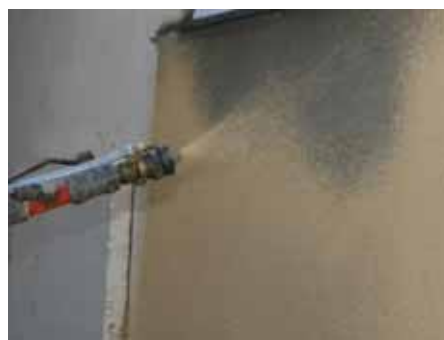
Obrázek 8: Stříkání omítky strojem PFT RITMO
