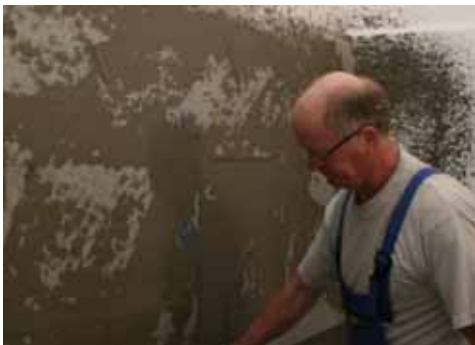
Obrázek 13: Zapracování síťoviny do stěrky
