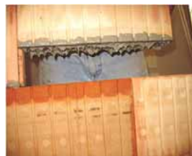
Osazování tvarovky do příčky (přesah min. 10 cm)
