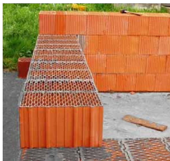
Tvarovky musí být položeny do 10 minut od nanesení lepidla.
