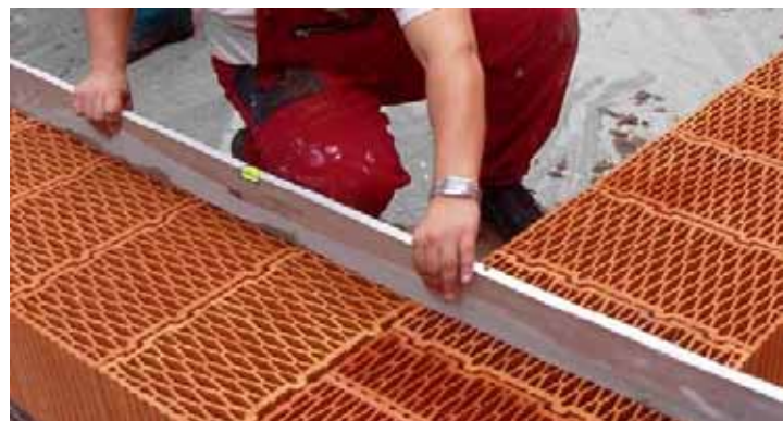
Kontrola a srovnání povrchu první řady
