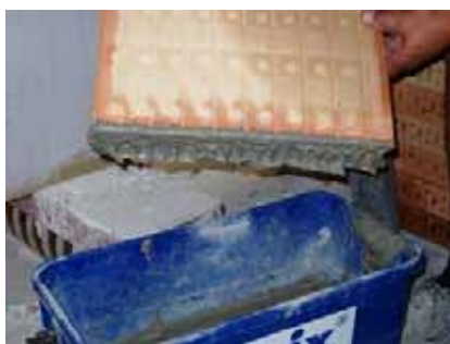
Namáčení tvarovky do malty (max. 5 mm)
