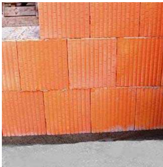
Po zavadnutí se zakládací malta seřízne do roviny
