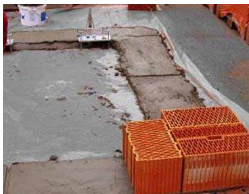
Skladba cihelných tvarovek na rohu
