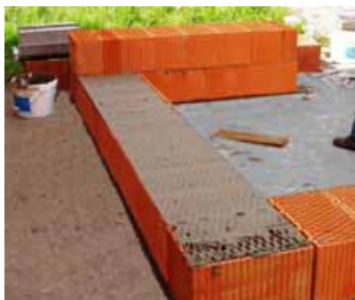
Celoplošně nanesená malta
