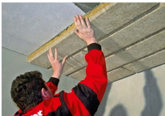
Obrázek č. 2: Lepení tepelněizolačních lamel na strop
